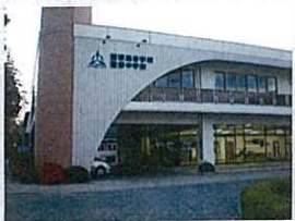
アプローチ側から見る
